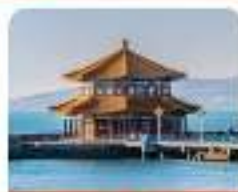
สะพานจางเจียว
